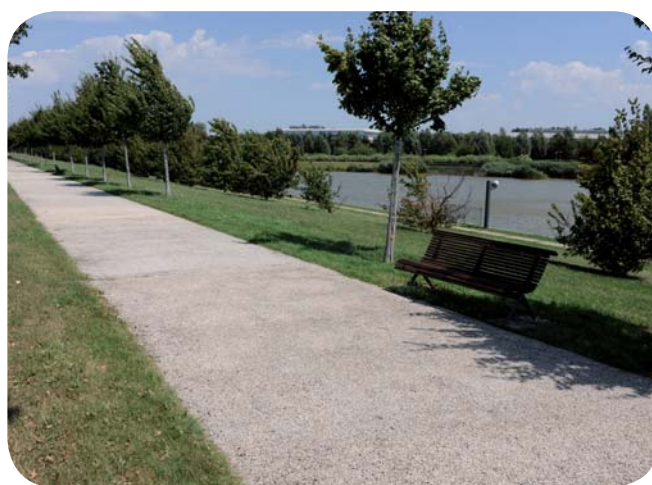
Chemin piétonnier en béton poreux
