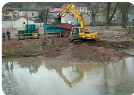
Arasement d'un atterrissement sur le Sornin
