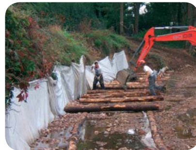
Réalisation d'un caisson végétalisé sur le Sornin
