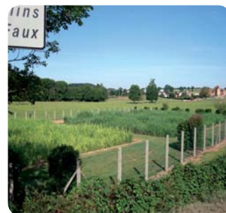
Filtre planté de roseaux en fonctionnement à Varennes
