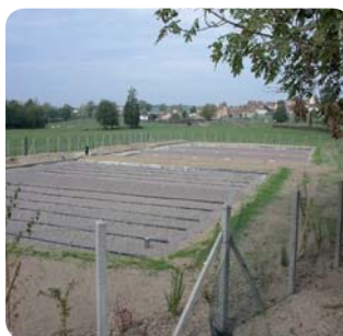
Filtre planté de roseaux à la fin des travaux à Varennes
