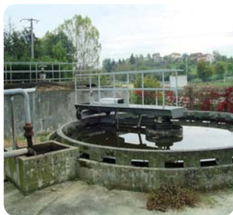
Station à boues activées - St Nizier
